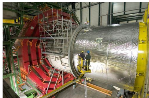
Figura 2.11: [33] Fotografía del solenoide del CMS durante su construcción.
